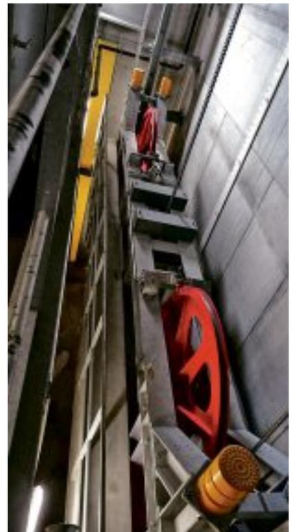
In Sedrun sind sowohl das Trag- wie auch das Zugseil mittels Gewichten abgespannt – hier das Zugseil in der Bergstation.
