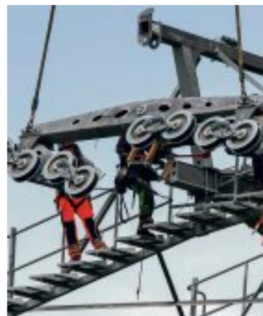
Dank spezieller Einhängenvorrichtungen an der Rollenbatterie wird die Montage mit dem Hubschrauber erheblich erleichtert.
