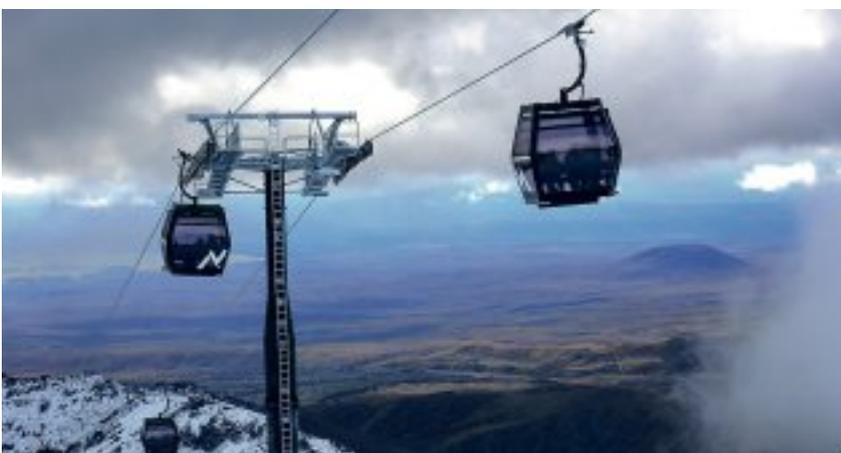
Auch die besonderen Wetterbedingungen machten technische Adaptionen notwendig: Aufgrund möglicher Windspitzen von bis zu 275 km/h wurden in den Kabinen der Bahn jeweils 80 Kilogramm an zusätzlichem Stahl verbaut.
