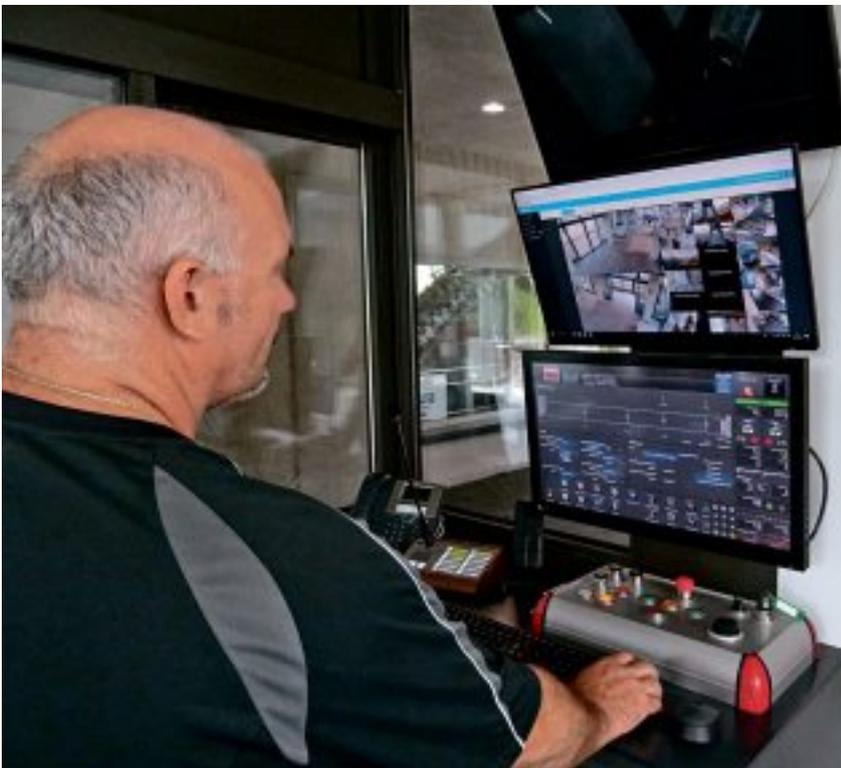
Dank eines audiovisuellen Überwachungssystems kann die Seilbahn ohne Kabinenpersonal fahren und von einem Mitarbeiter aus der Talstation bedient werden – die Steuerung wurde von der Frey AG aus Stans geliefert.
