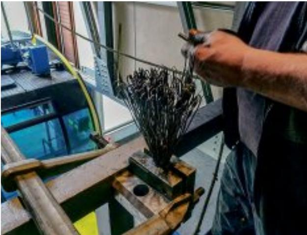
Die einzelnen Seildrähte werden zu „Widerhaken“ umgebogen, um in der Hülse die maximal stabilste Zugverbindung mit dem Vergusszylinder zu erreichen.
