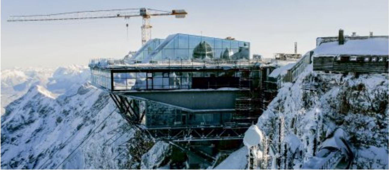
Zugspitze: Erst als Baucon die Idee entwickelte, die enormen Seilkräfte durch die Station hindurchzuführen und auf der südlichen Rückseite stufenweise abzuspannen, war der aktuelle Bau auf dem schmalen Gipfel des höchsten Bergs Deutschlands möglich.
