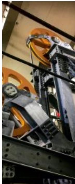
Die Gewichtsabspannung des Zugseils erfolgt über einen Spannturm im Talstationsgebäude.
