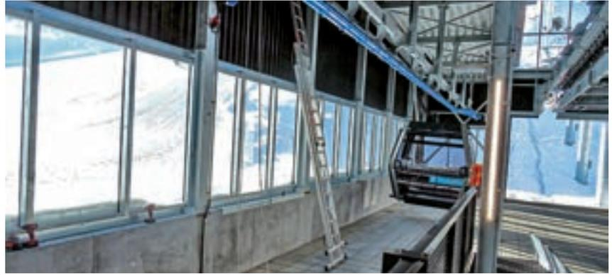
Ein Drittel der Kubatur eingespart: Die Kabinen werden mittels Stichgleisen im Stationsgebäude so angeordnet, dass auch die Zustiegs- und Aufenthaltsbereiche für die Skigäste zur Garagierung genutzt werden können.
