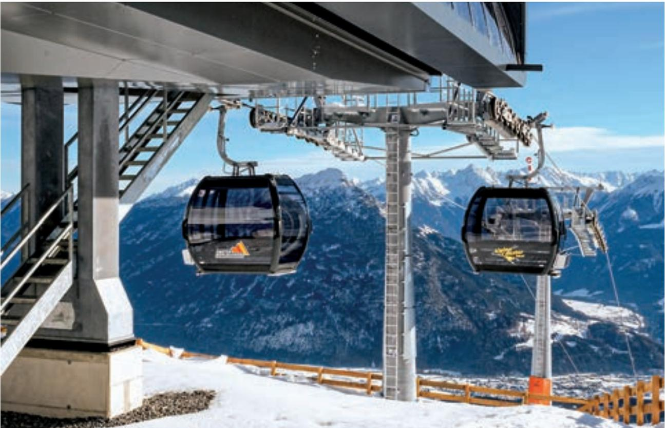
Mit einer Geschwindigkeit von sechs Metern pro Sekunde befördert die neue U-Alm-Bahn Wintersportler und Fußgänger in nur acht Minuten von der Tal- zur Mittelstation.
