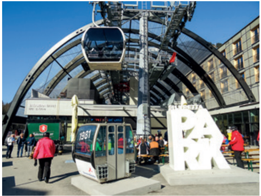
Die neue Talstation der Valiserabahn mit dem charakteristischen Folienbogen: „Durch diese vom Architekten Hans Obermoser realisierte Lösung wirkt die massive Kubatur der Station luftiger.“
