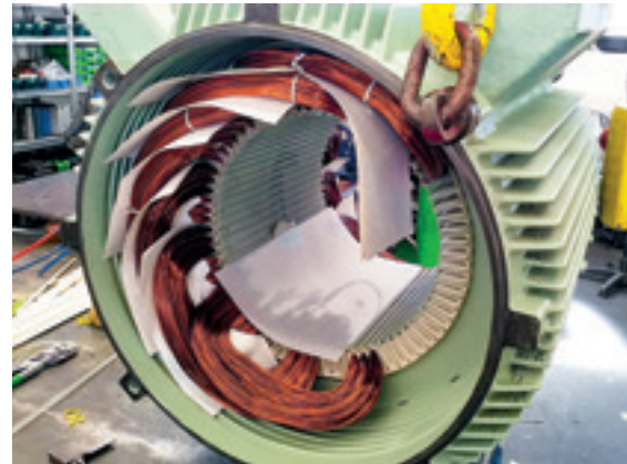
Seit mehr als 100 Jahren ist das Familien-Unternehmen Demmelbauer in Riedau i. I. Spezialist für Reparatur und Service von Antriebssystemen und damit gewissermaßen die Bodenstation für die Außendienst-Einsätze bei den Seilbahn-Kunden.
