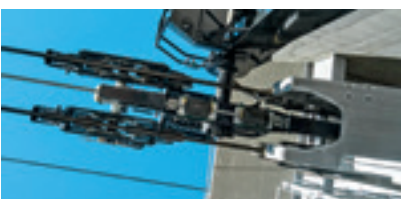
Die Anlage fährt ohne Fangbremse, hat also eine gespleißte geschlossene Zugseilschleife.
