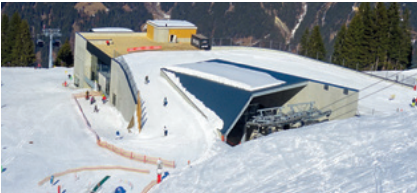
Planerische Glanzleistung von Salzmann Ingenieure: die Mittelstation, von oben gesehen. Hier zeigt sich, dass die umfangreiche Kubatur der Station und des Garagierungsbahnhofs weitgehend im Untergrund „vergraben“ wurde. Das Stationsdach wurde zu wertvoller Pistenfläche.
