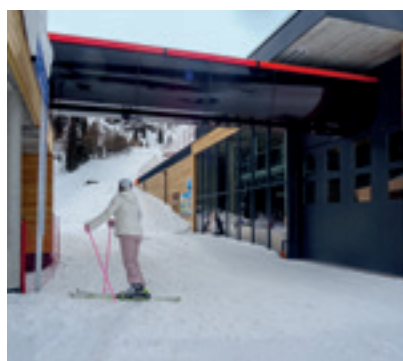
In der Bergstation ist der Garagierbahnhof von der Station abgesetzt, um dazwischen eine Durchfahrt zum benachbarten Bergrestaurant zu ermöglichen.
