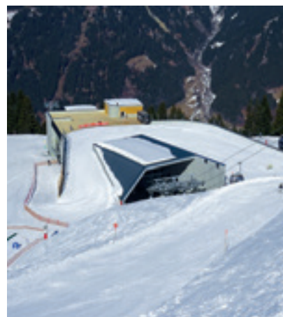
Bei der Mittelstation der Valiserabahn musste das Problem gelöst werden, die Skifahrer von der (bergauf) linken Pistenseite zur rechten Bergauf-Bahntrasse zu bringen – die Lösung: Das Stationsdach wird als Pistenfläche genutzt.
