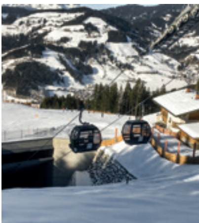
Auch bei der Flying Mozart war es die Herausforderung, die umfangreiche Kubatur der Mittelstation möglichst im Untergrund verschwinden zu lassen.
