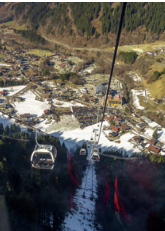
Valiserabahn: Salzmann Ing. verantwortete die Gesamtplanung der Anlage „ab der ersten Stütze“: Eine besondere Herausforderung war einmal mehr die starke Steigung unmittelbar nach der Talstation.
