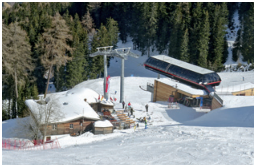
Referenzobjekt: Aus naheliegenden Gründen werden die Anlagen in Ladurns gern von Sterzing aus Kundendelegationen präsentiert.
