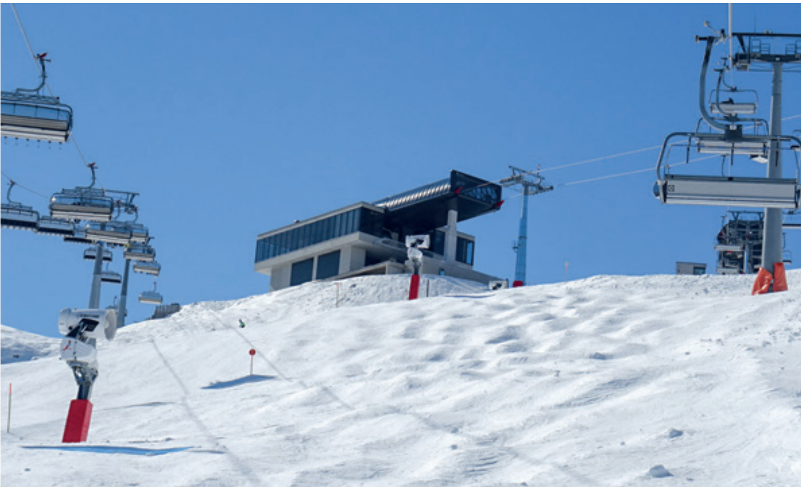
Die Bergstation im Zentrum des Skigebiets, ausgestattet mit einer leistungsfähigen Photovoltaikanlage.
