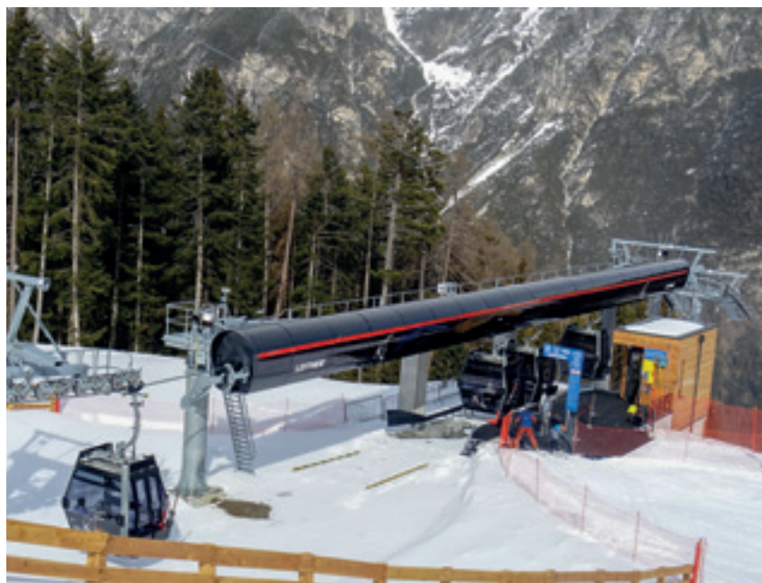
Technische Besonderheit: eine einseitige Mittelstation für den Zustieg in die Bergfahrt.
