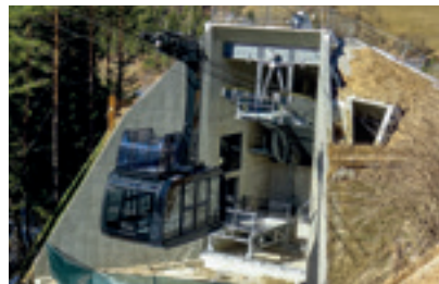
Die Stationen verschwinden unterirdisch im Gelände, sichtbar bleiben nur die Ein- und Ausgänge.
