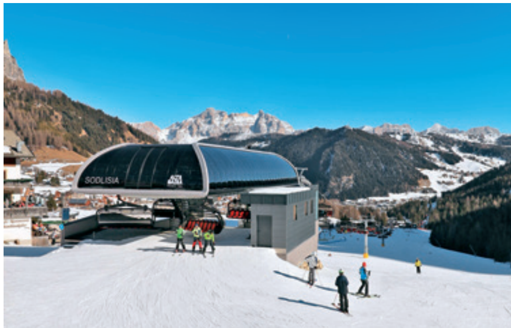
In Kolfuschg im Südtiroler Gadertal kann die 8er-Sesselbahn Sodlisia bei einer Länge von 785 Metern bis zu 3600 Personen pro Stunde befördern.
